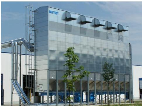
Вакуумные вентиляторы, используемые в фильтровальных установках Nestro, позволяют создать эффективную систему аспирации с низкой энергоемкостью за счет повышенного КПД вакуумной турбины. К вакуумному фильтру может быть подключено любое количество трубопроводов разного диаметра, без жесткой привязки к типоразмерам вентиляторов. Вакуумные вентиляторы для каждой системы подбираются под точно заданный расход
